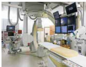
旧病院から移設した血管撮影室
