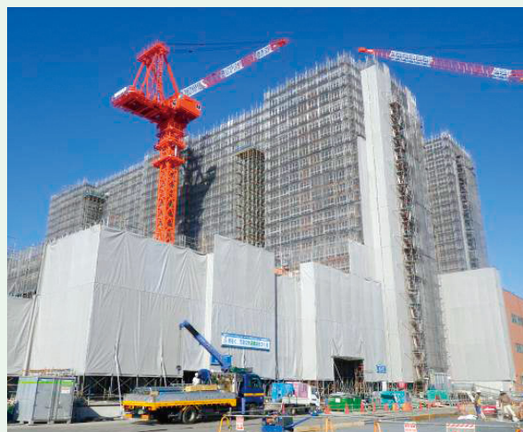
建物南側の工事状況（平成25年3月現在）
