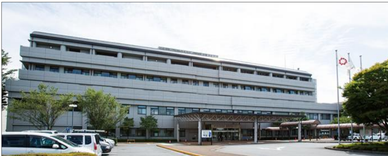
○循環器・呼吸器病センター
